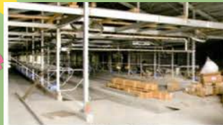
建設中の第二牛舎 熱対策として沖繩県初となるトンネル換気システムを採用したのだ。一般的なトンネル換気では空気を強制的に引き込み反対面から排出するが、中村さんの場合、換気扇を片面に並べ、陰圧で空気を強制
